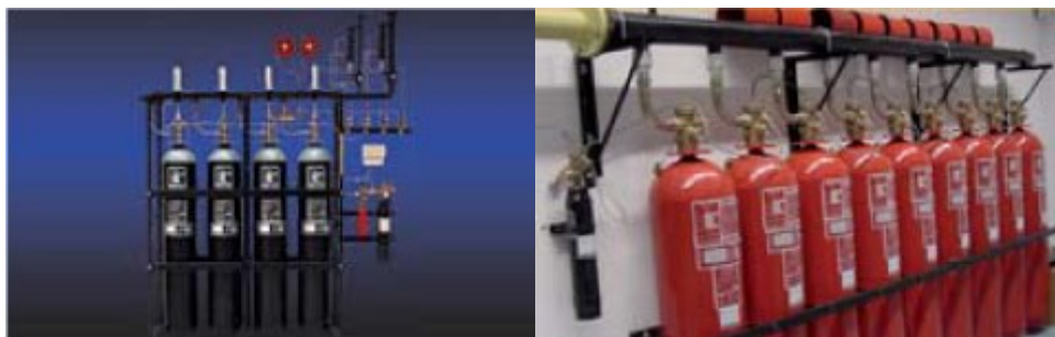
Obrázok 1: Plynové stabilné hasiace zariadenie [3]
