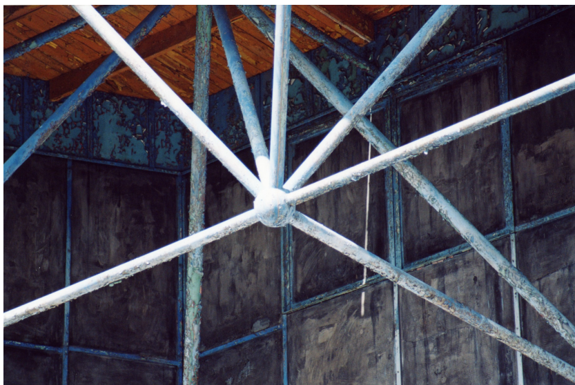
Obrázek 1.7: Příklad monolitického (rámového, tuhého) spojení prutů - spojené konce se nemohou vzájemně posunout ani pootočit
