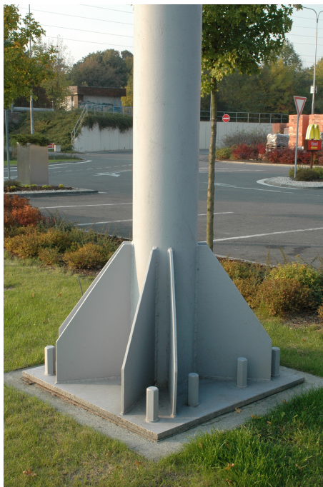
Obrázek 1.5: Vnější vazba - vetknutí: tento typ podepření brání posunutí i pootočení konstrukce.
