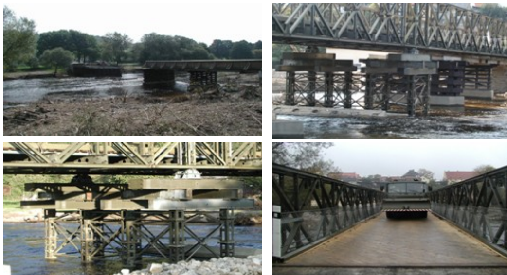
Obr. 3 Postup stavby mostního provizoria průzkum, stavba, zátěžová zkouška
