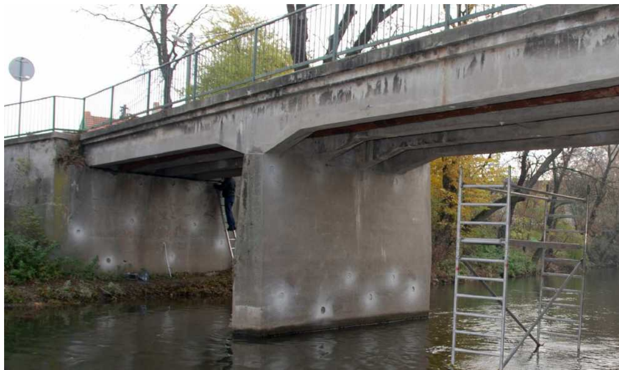
Obrázek 1 Most ev.č. Ko-M-2 v Kojetíně
