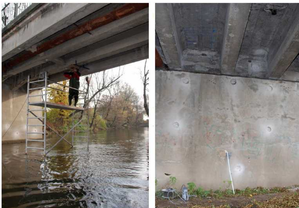
Obrázek 2: Levý – zjišťování množství, polohy a typu použité výztuže pomocí radiografické metody; Pravý – průběh výztuže mostovky
