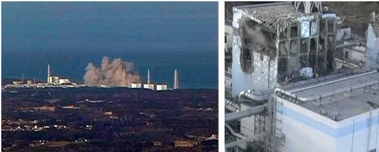
Obrázek 4 Výbuch na JE Fukušima a na část poškozené budovy bloku 4 (fotografie pořízené 17.3.2011)
