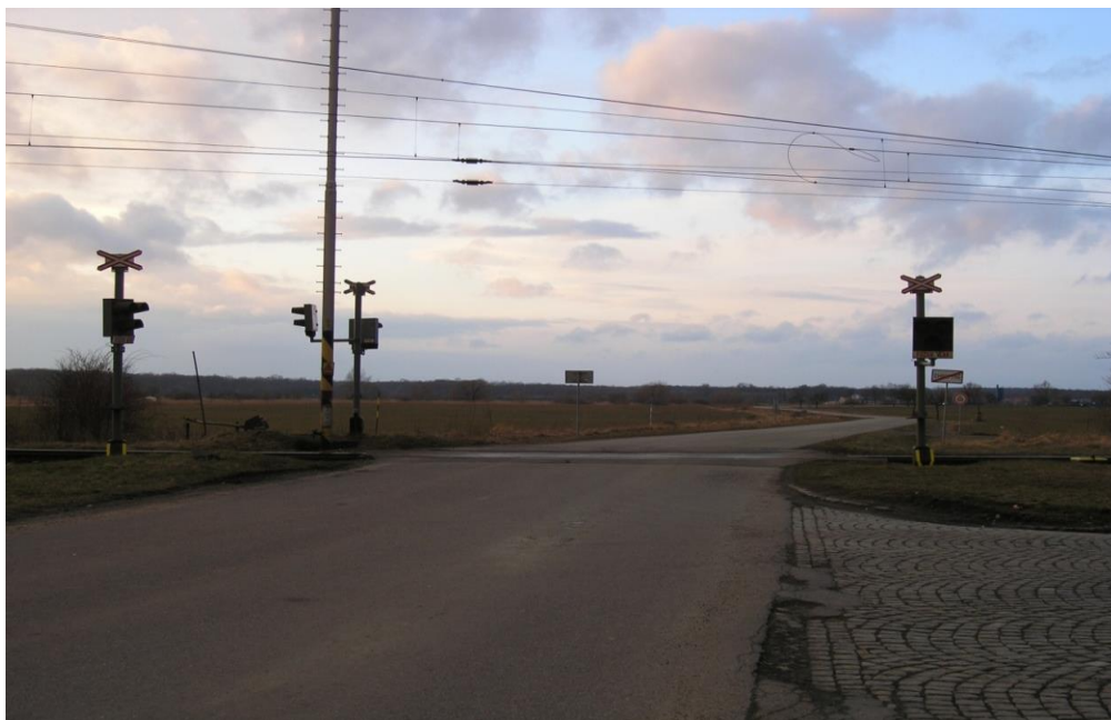
Obrázek 1 Železniční přejezd se světelnou signalizací v těsné blízkosti křižovatky se zabezpečením pomocí křižovatkového systému
