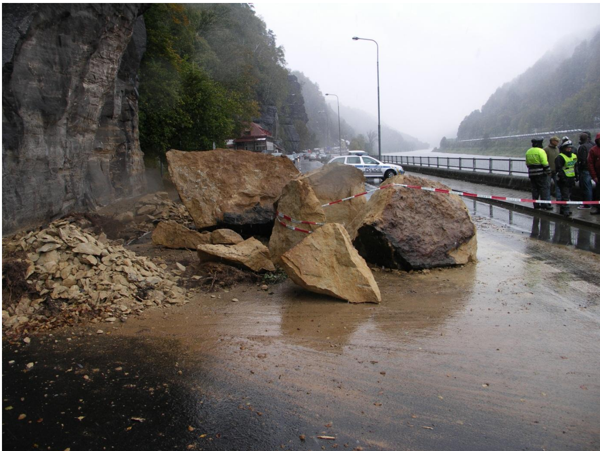
Obrázok 1 Spadlý skalní blok na silnici I/62 Hřensko - Děčín
