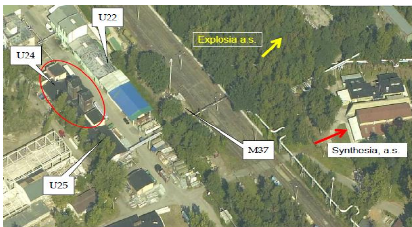
Obrázek 1 Šíření požáru z objektu U24
