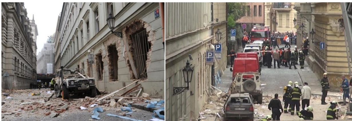
Obrázek 2 Poškozený dům po výbuchu plynu v Praze [2]
