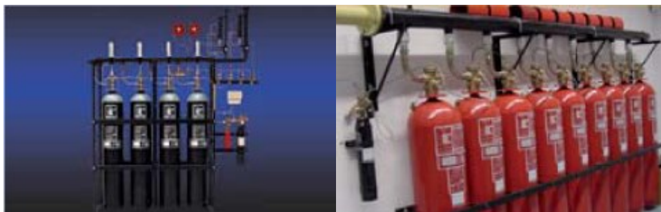
Obrázok 1: Plynové stabilné hasiace zariadenie [3]
